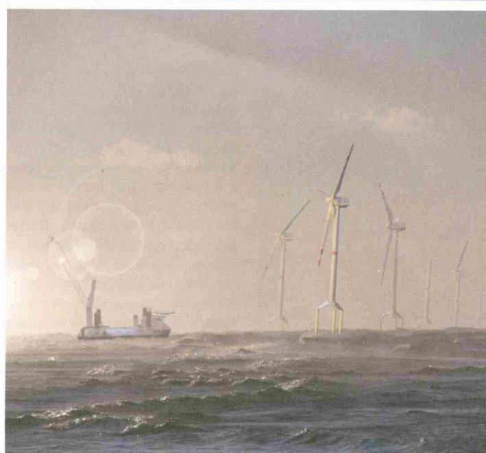
Ein Schiff zum Errichten von Windkraftanlagen: Ab Ende Mai 2009 soll „Windlift 1“ insgesamt 80 Windräder zur Stromgewinnung vor Borkum in den Meeresgrund „einpflanzen“.
