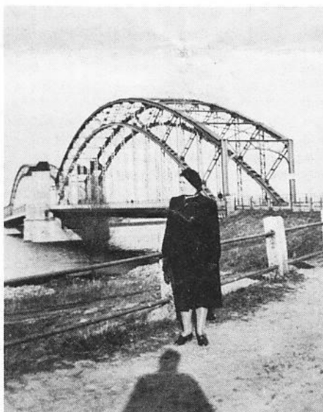
Im Oktober 1914 wurde die Petersbrücke eingeweiht. Sie wurde im Oktober 1944 so gründlich gesprengt, daß die Russer danach wieder auf eine Fähre angewiesen waren. Bild A. Mauritz
