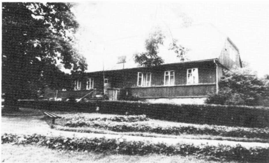
Das Gutshaus von Kölmisch Prökuls ist vermutlich das älteste von den noch erhaltenen Gebäuden aus dem 18. Jahrhundert in Prökuls; erbaut etwa um 1765.
