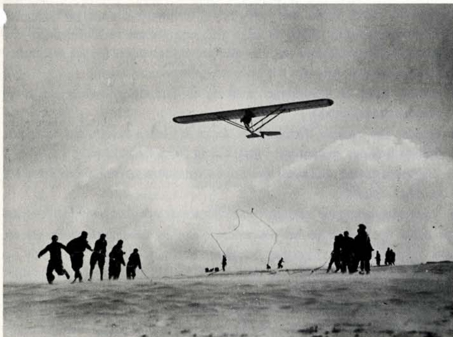
Segelflugzeugstart auf Rossittens Dünen – per Gummiseil
