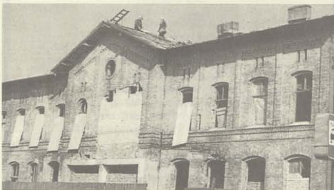
Der alte Memeler Bahnhof wird renoviert und erhält ein neues Dach.
