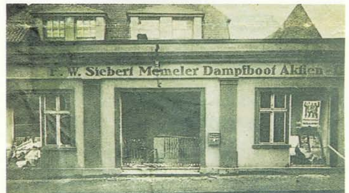
Am 17. Oktober 1925 wurde auf das MD-Haus ein Sprengstoffanschlag verübt
