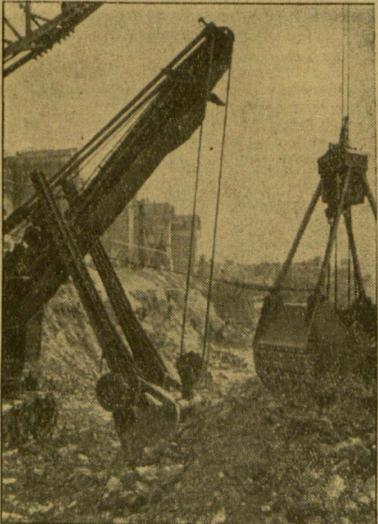
An den Küsten entstehen immer neue U-Boot-Bunker. Wieder sind einige tausend Kubikmeter Beton geprengt worden und die Bagger schaffen Raum für den fortschreitenden Bunkerbau.
