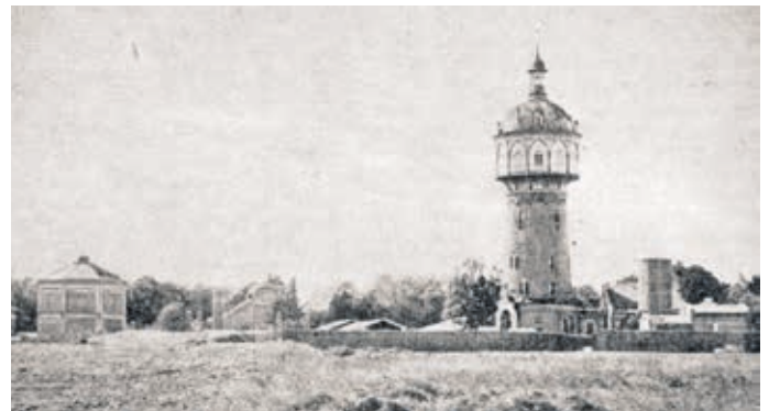
... bis kurz vor dem Wasserturm in der verlängerten Alexanderstraße, wo sich die Vorschule befand.
