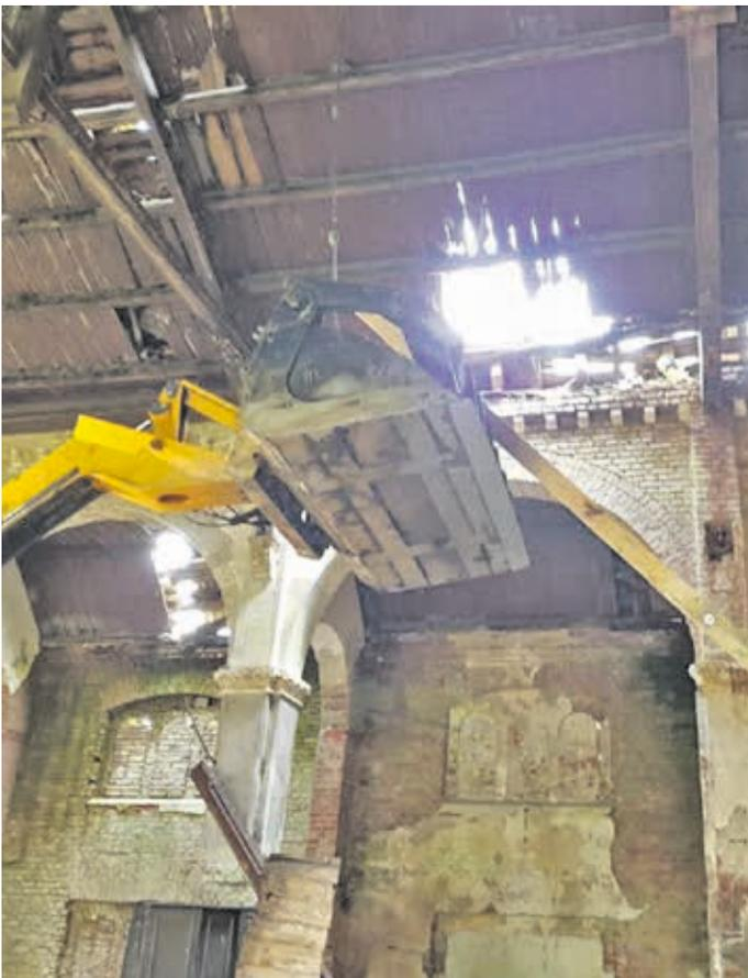
Stützbalken zur Sicherung des Dachstuhls werden eingesetzt.
