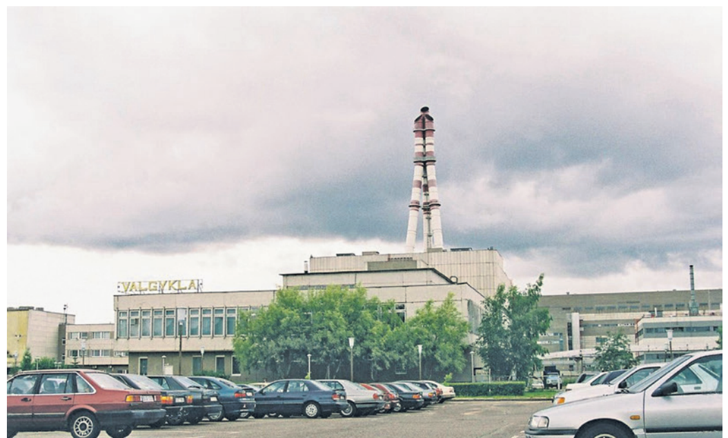
Der Rückbau läuft auf Hochtouren. Das Atomkraftwerk Ignalina.
