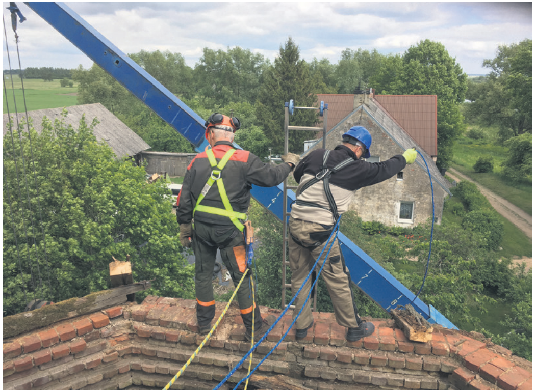
Abbau des Dachstuhls der Apsis.
