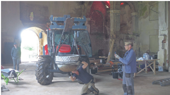
Das Oberteil des Taufbeckens wird in die Kirche gebracht.
