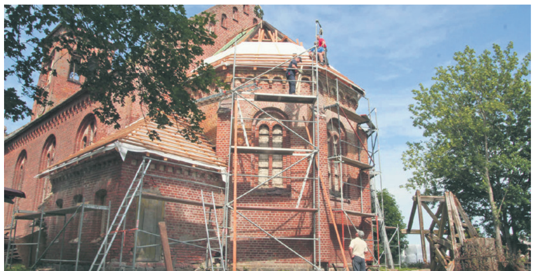
Maurer- und Dacharbeiten an Sakristei und Apsis.
