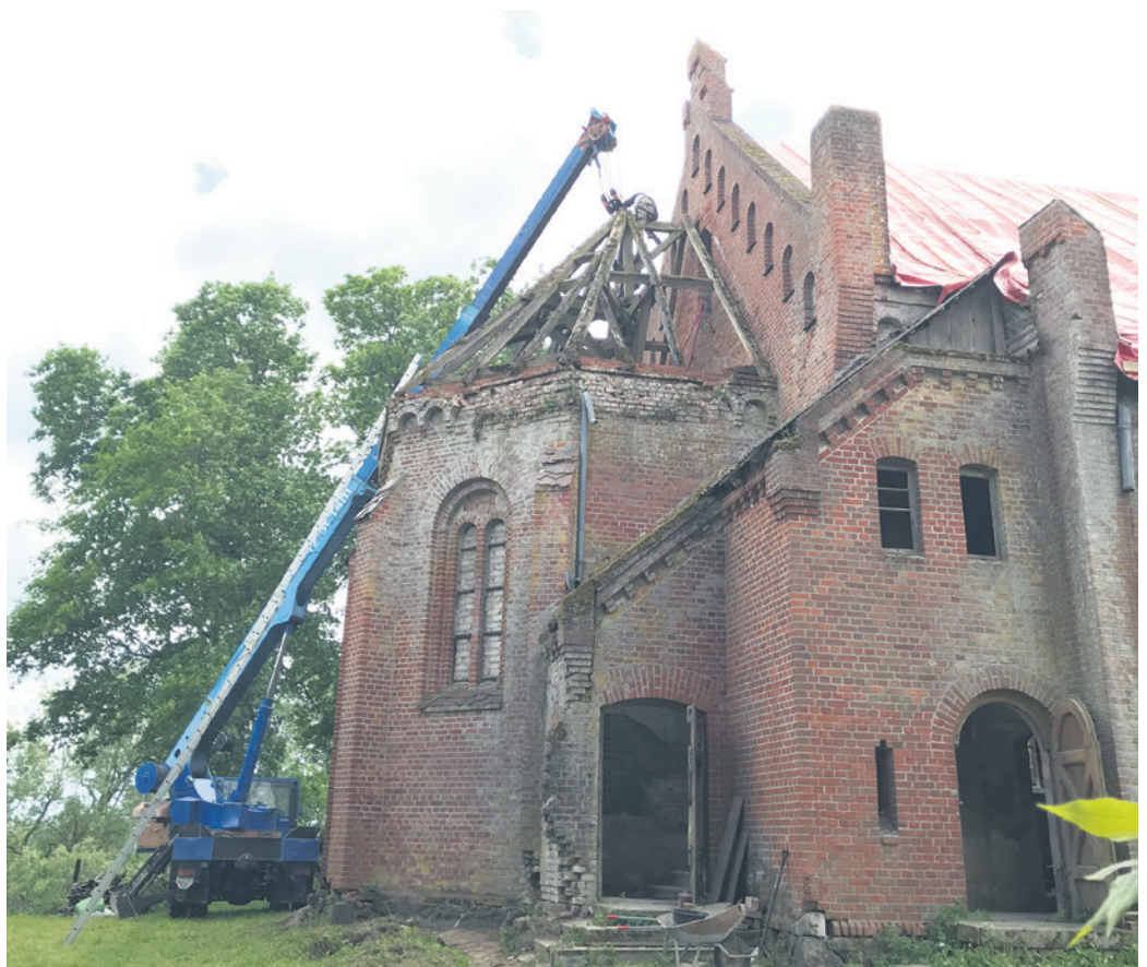
Abbau des alten Dachstuhls der Apsis.
