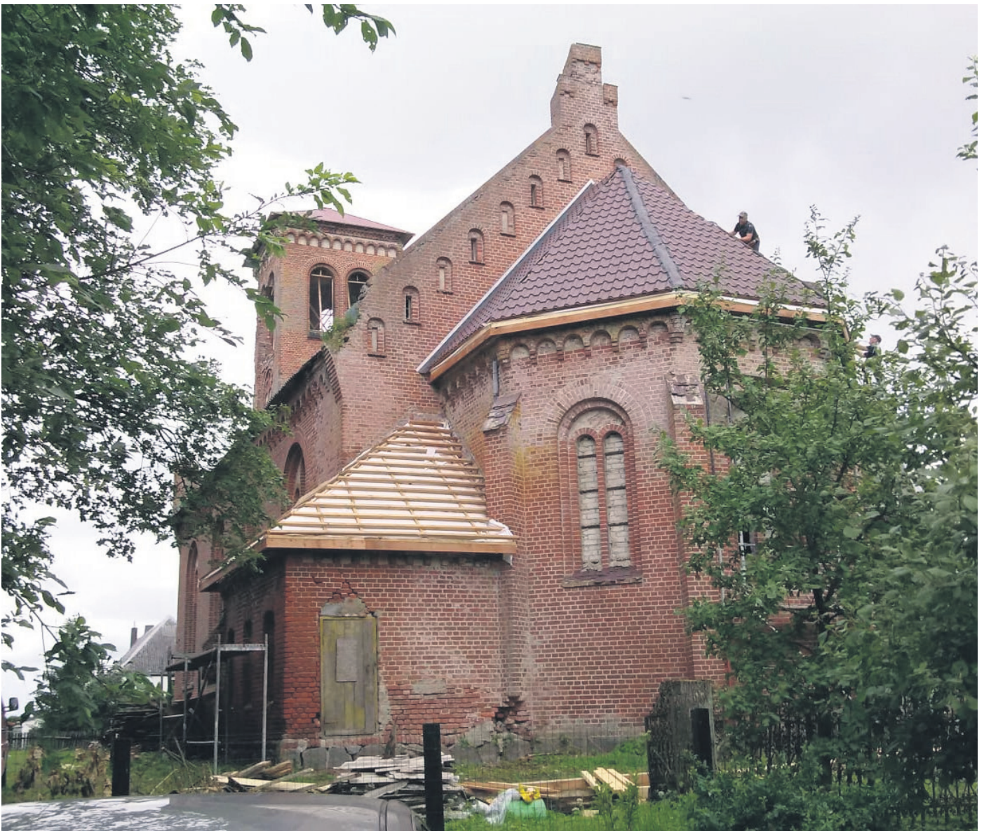
Das Dach der Apsis ist schon eingedeckt.
